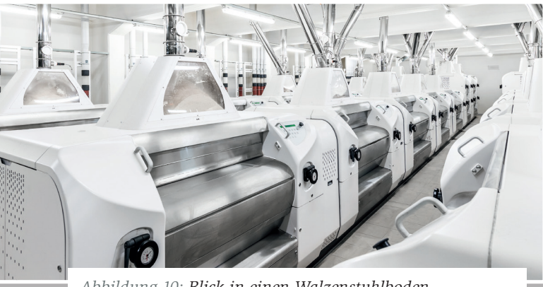
Abbildung 10: Blick in einen Walzenstuhlboden
